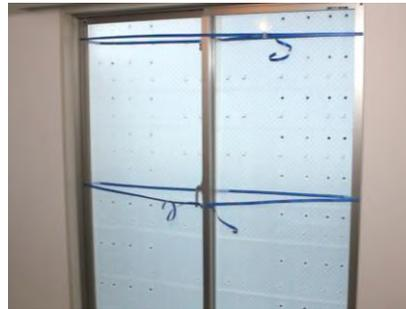
プラダン窓ガードは、プラダンを窓の外側に取り付けることで、強風による飛来物から窓を守る商品です。
