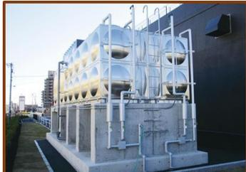
災害時の断水に備えて最大20 tの水を貯水できるタンクを完備しております。
