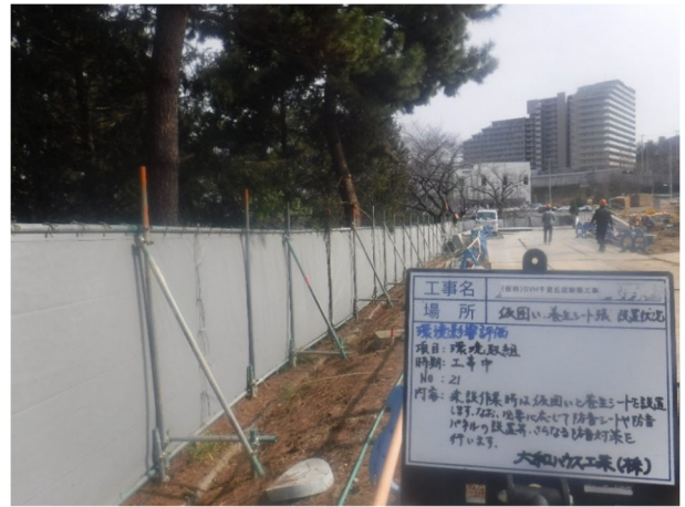
仮囲いシート設置
