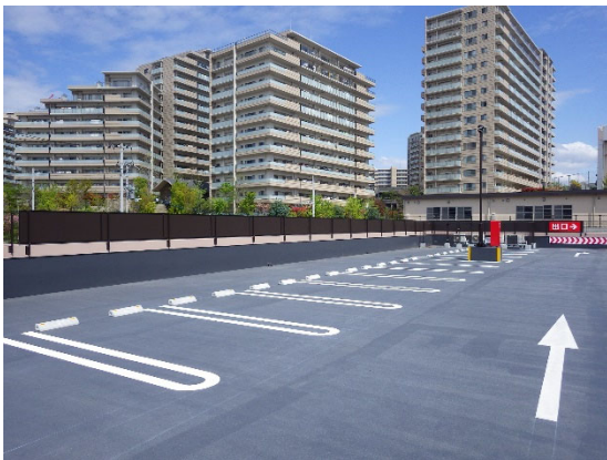
写真7 (目隠しフェンス)
