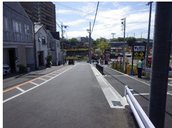
写真 16 (南側出入口前面道路の拡幅)
