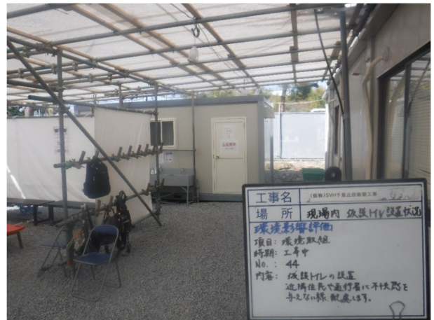
仮設トイレ設置
