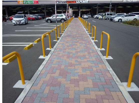
写真4 (インターロッキングブロック)
