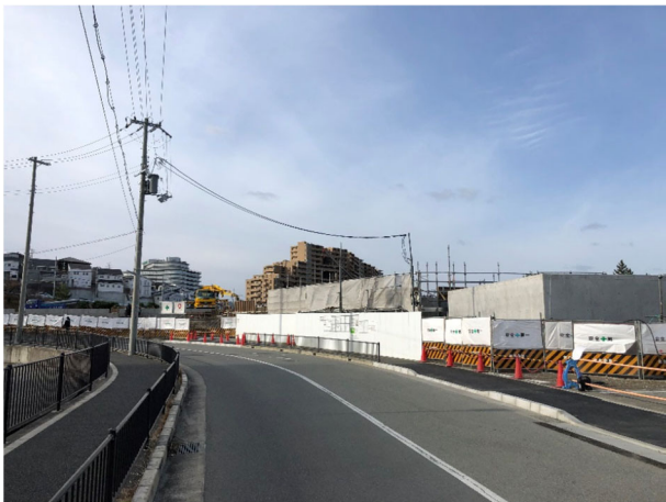
仮囲い設置 養生シート、フラットパネル、 フェンスバリケード+シート
