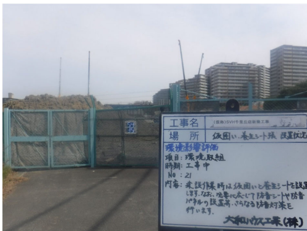
仮囲い養生シート 騒音計、振動レベル計設置
