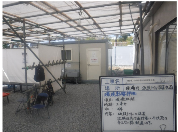
仮設トイレ設置
