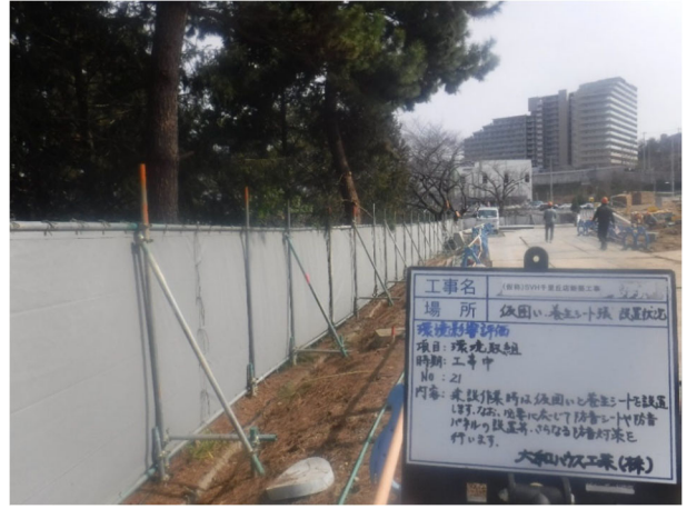
仮囲いシート設置
