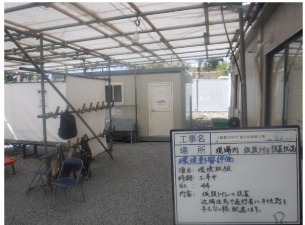
仮設トイレ設置
