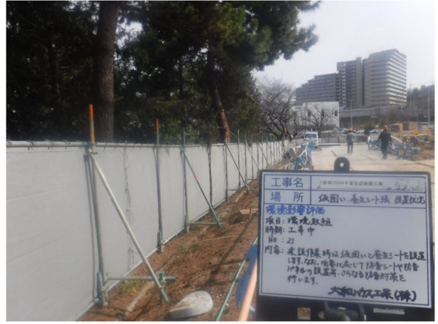
仮囲いシート設置
