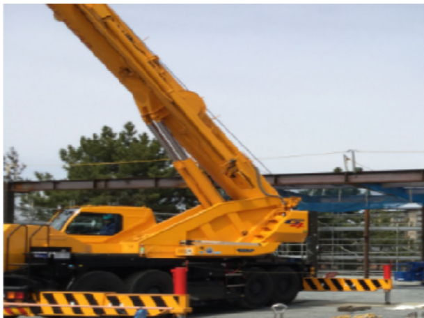
ラフタークレーン (70t)
